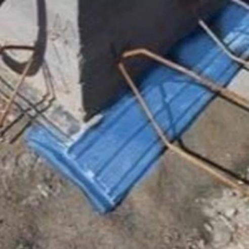
Waterstop-ul SEALPVC RG 250 este un profil impermeabil din PVC, non hidroexpansiv, cu o lățime de 25 cm și o elasticitate ridicată. Se folosește în îmbinări statice pentru turnare orizontală (dale), în structuri de beton, sprijinit pe substrat sub armătură.
